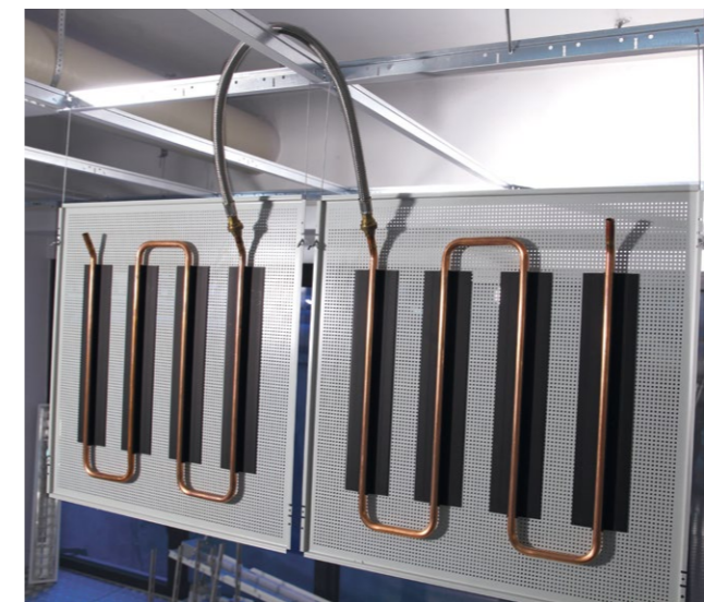
Fig. 2.6 Ispezionabilità del controsoffitto radiante GK PSV – pannelli attivi e passivi sospesi con cavetti
