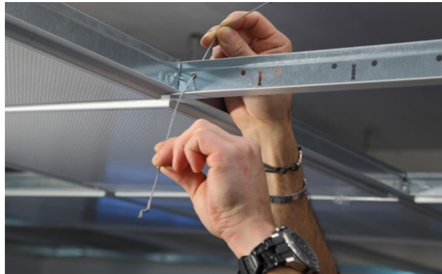
1. Si infilano i cavetti metallici PGK negli appositi fori dei portanti
