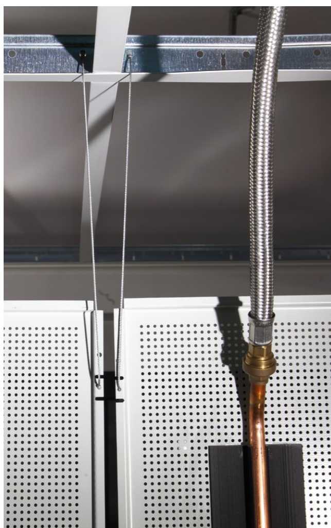
Fig. 2.8 Collegamento in serie dei pannelli con attivazione C75 con kit preassemblati
